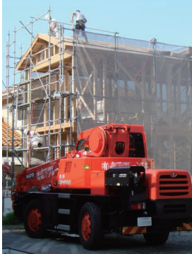
クレーンにて建て方
